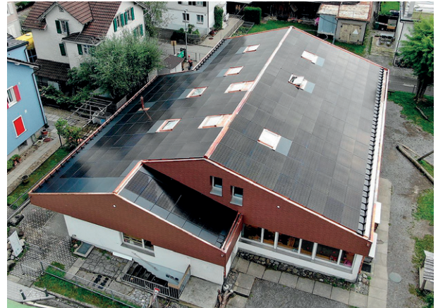
Neue, integrierte PVA auf dem Kindergarten Grund
