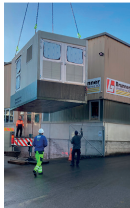
Neue Trafostation Brunner, Glatthalde
