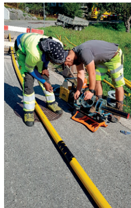
Sanierung Werkleitungen Bühlstrasse Degersheim
