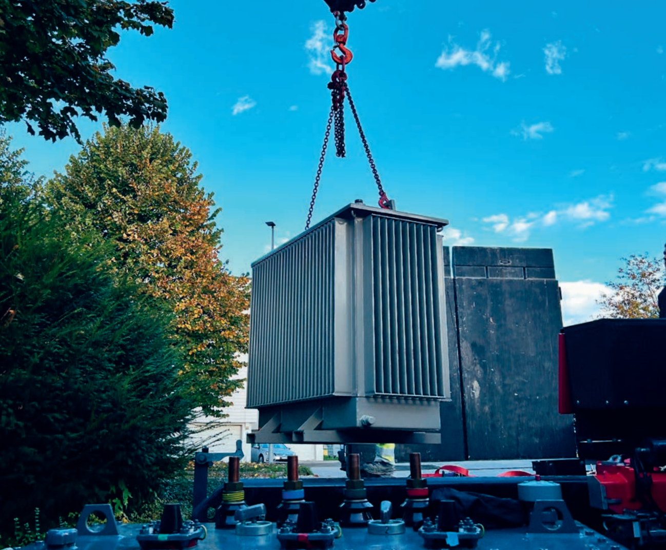
Ein neuer Trafo wird per Lastwagenkran bei der sanierten Trafostation Mühlebach abgeladen.
