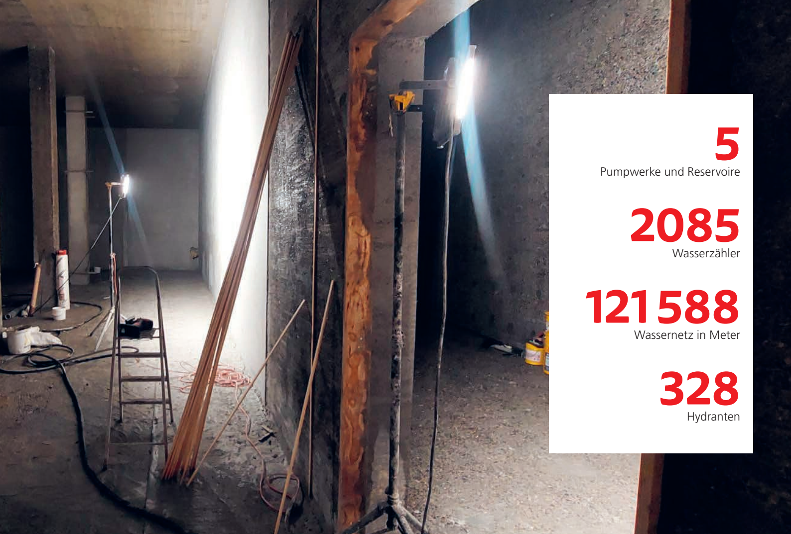
Aktueller Stand der Sanierungsarbeiten im Reservoir Magdenau.
