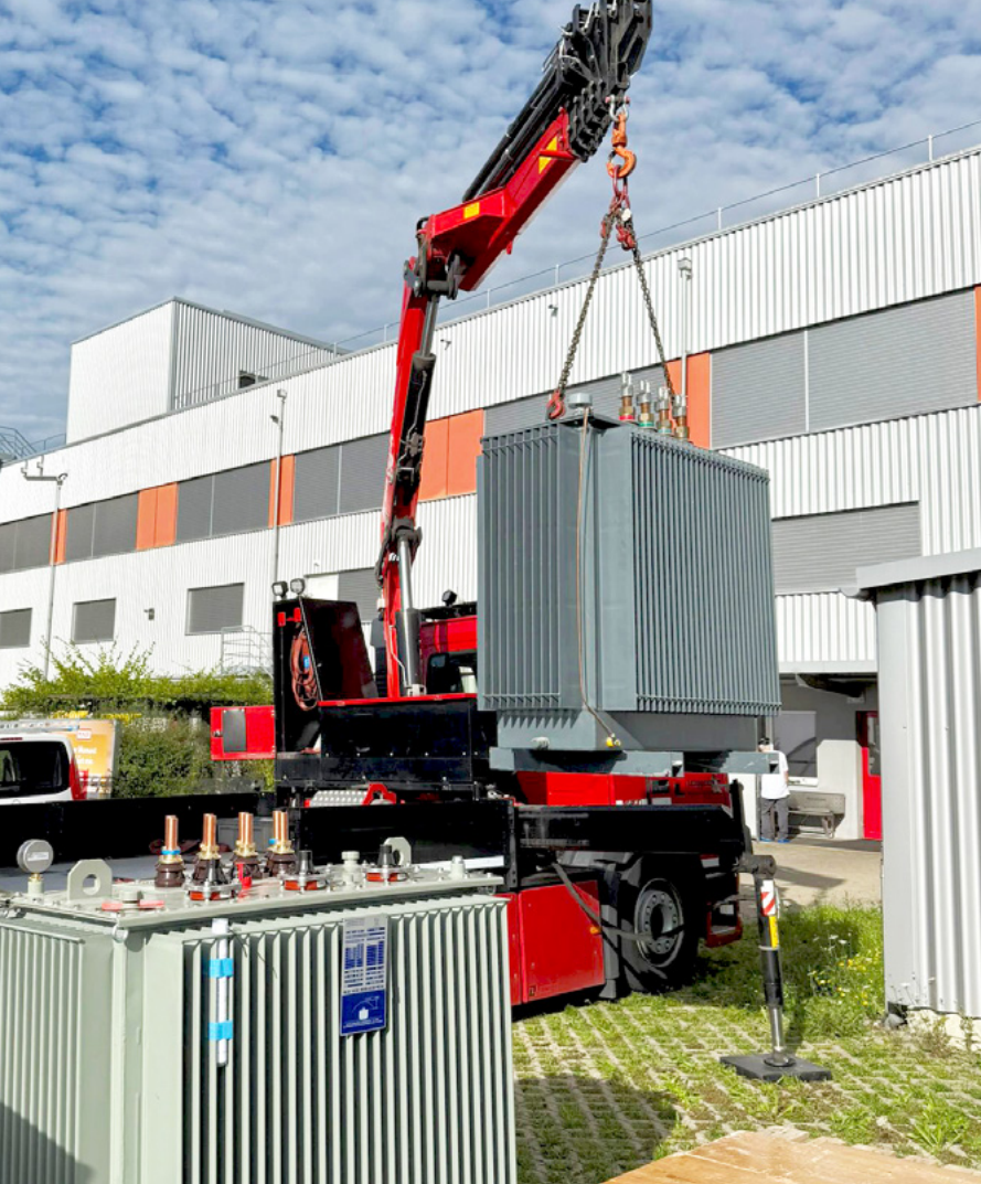
Der alte Transformator in der Rudlen wird durch einen neuen ersetzt.
