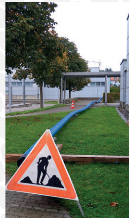
Burst-Lining am Fohlenweg
